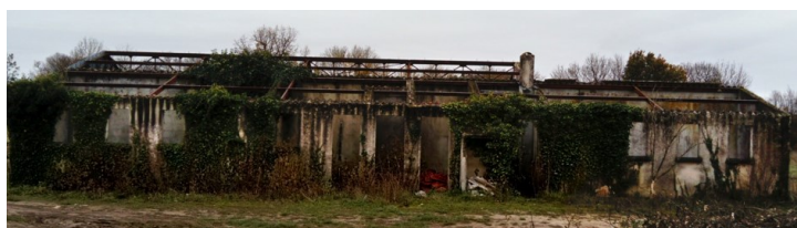
Le premier permis a été accordé à la mairie pour démolir ces ruines.
